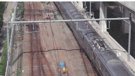
図2-32-2 鋼管架線柱
