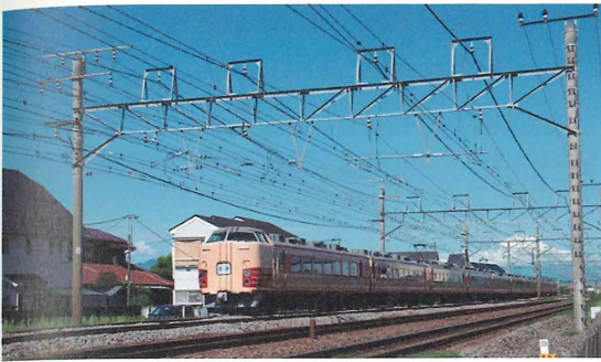
図2-32-1 PC架線柱
